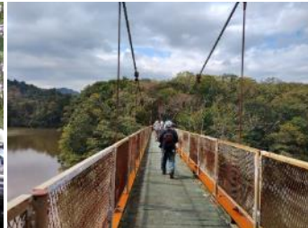
吊り橋の高さは10m以上
