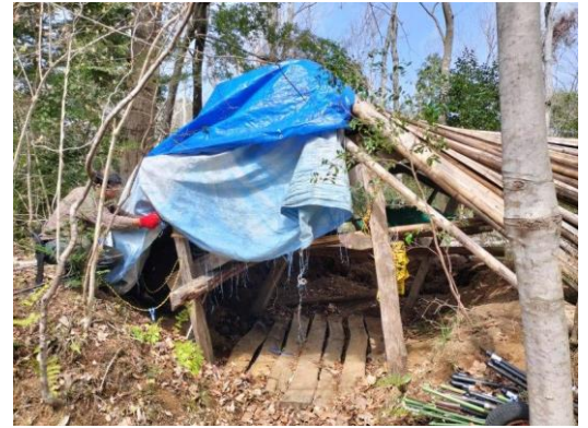
改修前の物置
