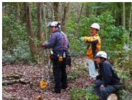
チルホールでの牽引
