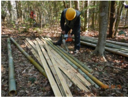
伐採竹は屋根材用に縦割り
