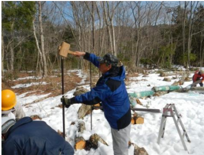
支柱を打ち込み
