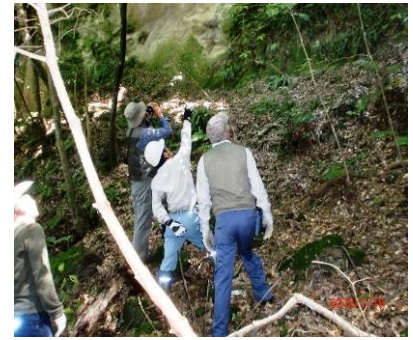
健脚組による崖地調査
